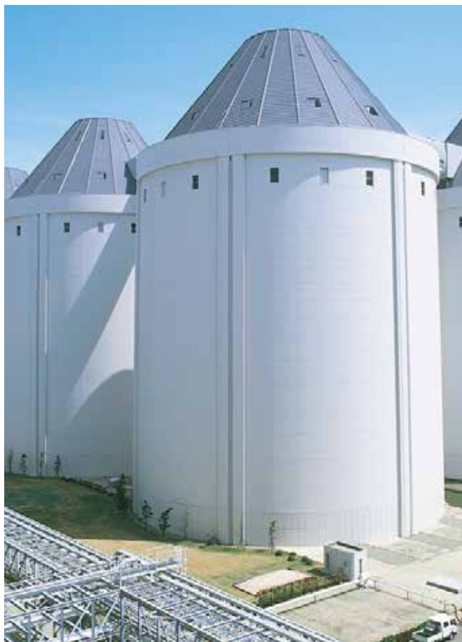
ボンフロンHBC-SR 電源開発橋湾火力発電所サイロ
