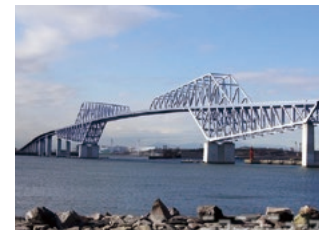
東京ゲートブリッジ
